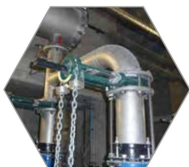
Vanne à guillotine DN 150 avec commande par volant à chaîne plus guide chaîne.
